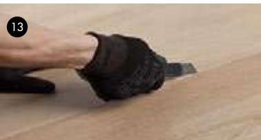
13- Avant d'effectuer le jointolement, s'assurer que le matériau d'adhérence a durci. Retirer les restes de croisillons, nettoyer les joints de pose sur toute la longueur, la largeur et la profondeur, puis vérifier qu'il ne reste pas d'humidité à l'intérieur du joint.
