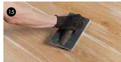
15- Respecter les recommandations du fabricant pour la préparation et l'utilisation des matériaux de jointolement. Vérifier que le matériau et les outils choisis n'endommagent pas la surface de la céramique. Le matériau de jointolement s'applique à l'aide d'une taloche en caoutchouc. Dans les catalogues de VENIS, vous trouverez le matériau de butech recommandé pour chaque modèle.
