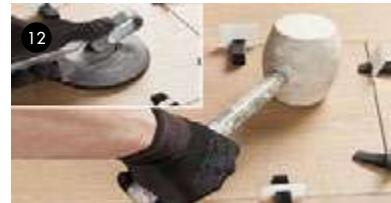
12- Pendant la phase de pose et avant de terminer la journée, contrôler la qualité du travail réalisé avant la fin du temps de manipulation du matériau d'adhérence, puis corriger les défauts en utilisant des ventouses et des maillets en caoutchouc.
