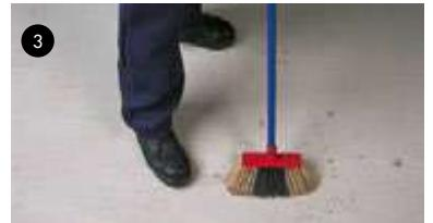
**3-** La surface de pose du revêtement doit être parfaitement propre, exempte de poussière ou de toute autre substance qui pourrait nuire à l'adhérence des carreaux. Pour les poses spécifiques (systèmes de chauffage au sol, façades à ancrages mécaniques, céramique sur plafond ou paramètres particuliers du projet), demander des informations précises supplémentaires pour chaque situation.
