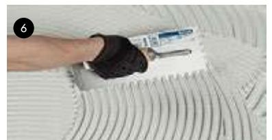
**6-** Nous recommandons uniquement le système de pose en couche mince avec taloche crantée. Pour les carreaux dont le format est supérieur à 1000 cm<sup>2</sup> (33x33 cm), il est recommandé d'utiliser la technique du double encollage, c'est-à-dire d'appliquer la colle aussi bien sur le support qu'au dos du carreau.
