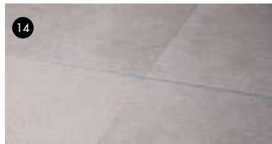
14- Le remplissage des joints doit être effectué une fois que les carreaux sont parfaitement collés au support. Dans le cas des revêtements de sol, respecter les recommandations du fabricant de mortiers-colles, afin d'attendre le temps nécessaire avant de marcher sur le carrelage ou de le soumettre à une charge quelconque. Cela permet d'éviter les décollements ou les cassures prématurées.
