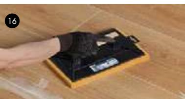
16- Attendre que le matériau de jointolement commence à sécher puis nettoyer à l'aide d'une éponge humide et de l'eau propre. Ne pas laisser le matériau de jointolement durcir sur la céramique, en particulier sur les carreaux en relief. Ne pas humidifier les joints avec une trop grande quantité d'eau.
