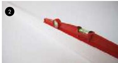
**2-** S'assurer que le support du revêtement est stable et que le fond de pose est adapté à la céramique : surface à la texture rugueuse non friable, parfaitement nivelée et sans défaut de planéité. Il est recommandé d'imperméabiliser les environnements humides.
