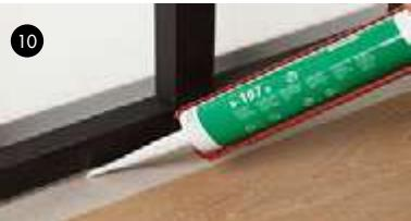
10- Les joints périphériques doivent être situés dans les angles, les changements de plan du sol et au niveau des changements de matériaux. Il est recommandé de les couvrir avec la plinthe ou le carreau et de sceller avec un mastic élastique.
