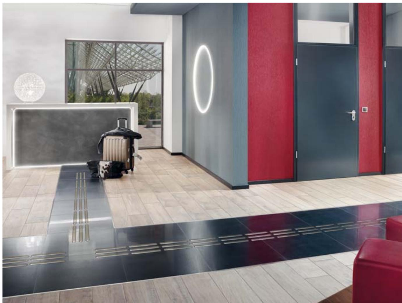
**AIDES TACTILES À L'ORIENTATION CONFORMÉMENT À LA NORME DIN**
