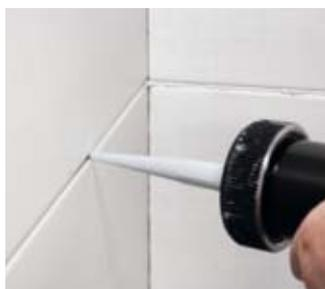
Utiliser SPEED-FLEX dans le joint
