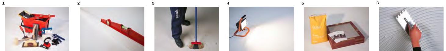
1. La colocación de cerámica requiere de personal cualificado, con experiencia demostrada y herramientas y útiles adecuados: llanas dentadas, crucetas, mazos de goma, ventosas para la colocación y llanas de goma, esponjas y cubetas para el rejuntado. Revisar previamente la información contenida en los embalajes y respetar escrupulosamente las recomendaciones del fabricante.
