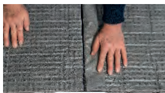
Pose de la natte de drainage DURABASE DR 100 avec chevauchement
