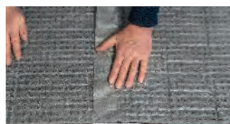
Pose de la natte de drainage DURABASE DR 100 avec chevauchement
